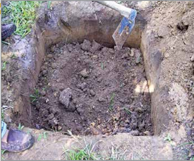
Masukkan tanah lapisan bawah ke atas campuran tanah lapisan atas dan gaul dengan lebih baja asas dan padatkan. Biarkan membusut sedikit.
